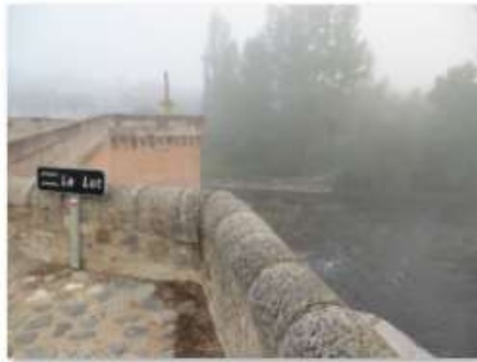
02_2014-09-26_04_Brücke über den Lot.jpg
